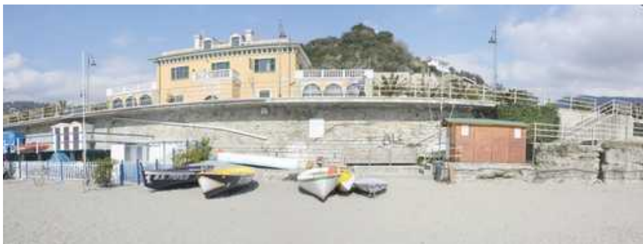
Figura 6 – Panorama dalla spiaggia (ripresa fotografica antecedente l'inizio dei lavori)
