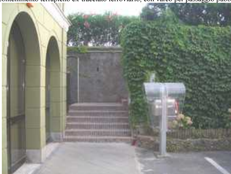
Figura 3 – Collegamento tramite scalinata con la strada provinciale (fianco dx Municipio)
